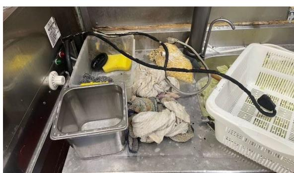
清理起火處發現瓦斯管線燒熔情形
