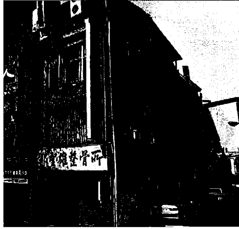
背(側)向立面照片
